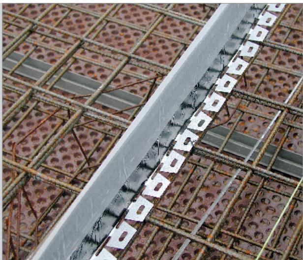
Brtvljenje spojeva betonskih konstrukcija zahtijeva vrlo pouzdane brtvene materijale.
