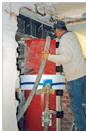
Tubbox® Multi - primjena na gradilištu
