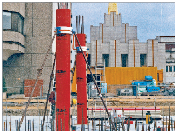
Vertikalno fiksiranje izvodi se vrlo jednostavno, korištenjem podupirača i glave sa remenom za zatezanje posebno dizajniranih za ovu namijenu.
