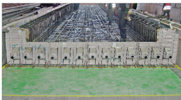
Kompletan oplatni element kombiniran sa Egcodorn i Stremaform sistemima, za izvedbu dilatacijskih reški
